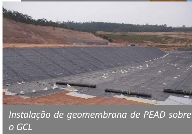
*Instalação de geomembrana de PEAD sobre o GCL*
