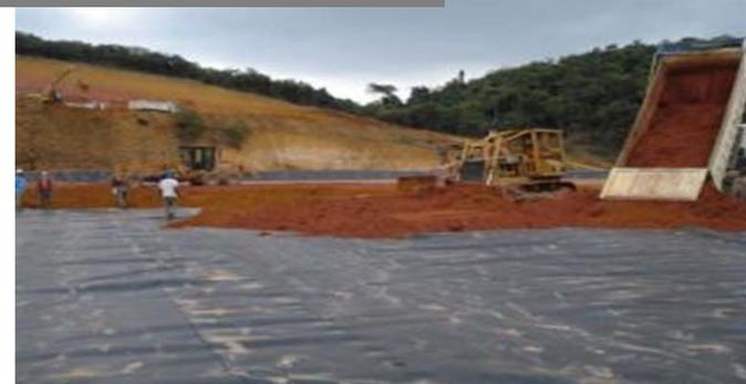
*Proteção mecânica da manta de PEAD com solo*
