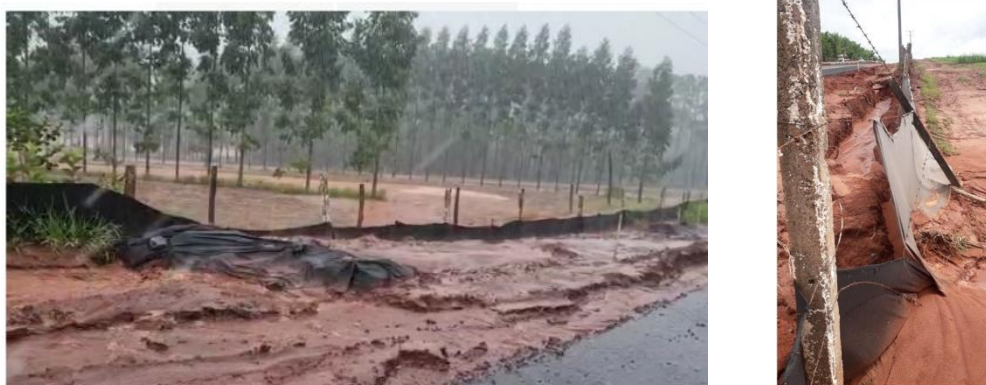
Figura 14 - Entrada de água escoada da rodovia SP 333, para o carreador na divisa entre a rodovia e a área experimental da APTA/URPD de Assis.
