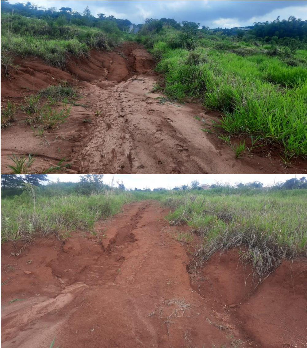
Foto 3. Feições erosivas observadas em visita ao local.
