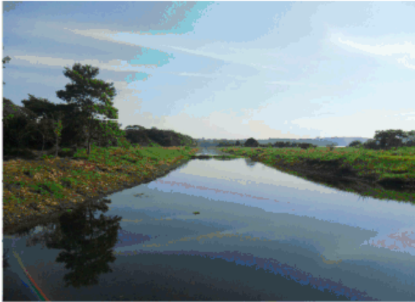
Fig. 2. Vista do canal de sucção
