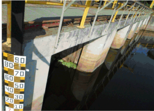
Fig. 3. Detalhe da entrada dos poços de sucção
