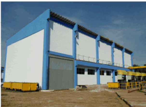
Fig. 4. Vista externa da casa de bombas
