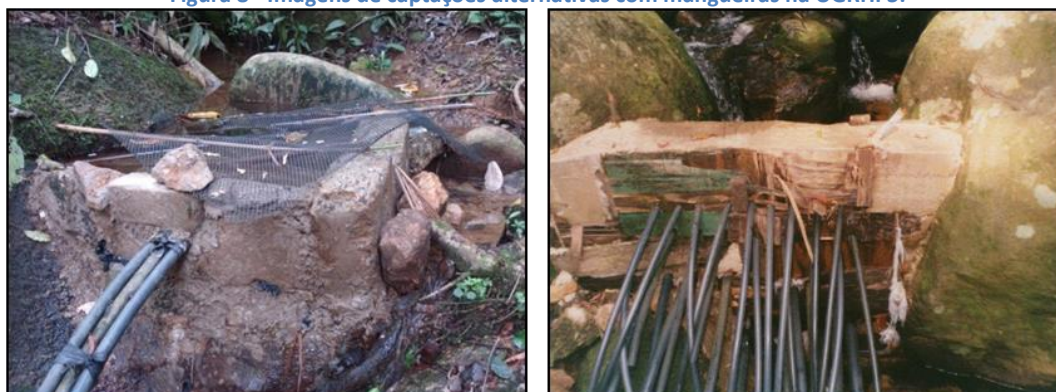
Figura 8 - Imagens de captações alternativas com mangueiras na UGRHI 3.
