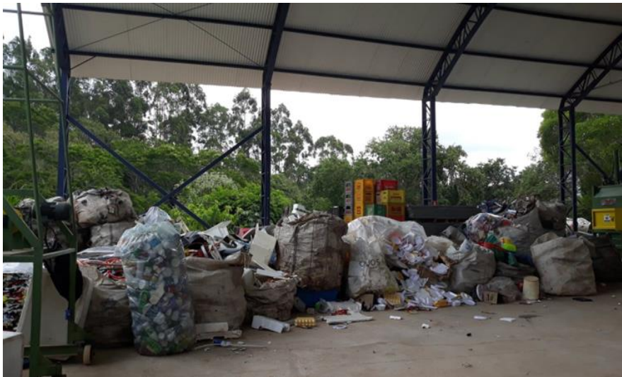
Figura 14- Fotos das instalações físicas da COOPERARES
