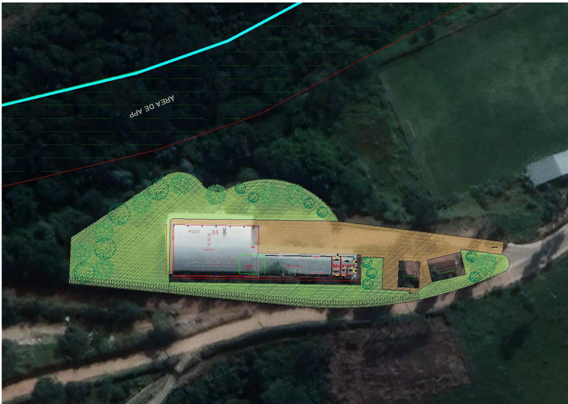
Figura 31 - Localização do galpão utilizado pela COOPERARES - incidência de APP.
