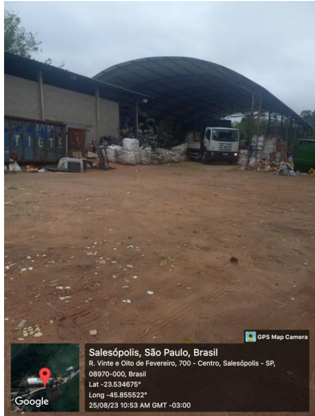
Figura 10- Fotos das instalações físicas da COOPERARES
