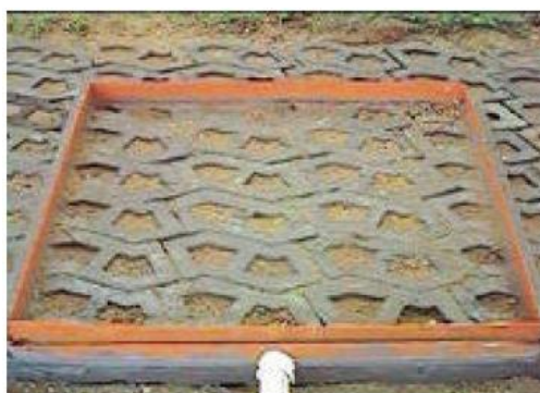
Figura 154. Blocos de concreto vazados (Araújo Tucci, Goldenfun, 2000)
