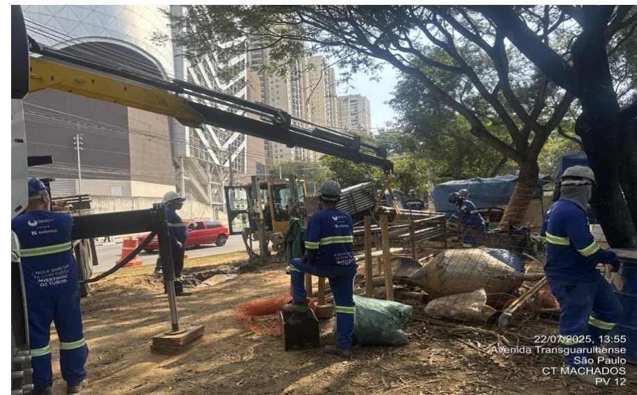
Execução de passagem de tubos
