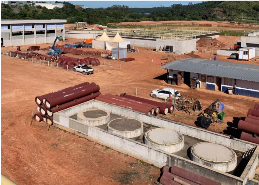
Vista Aérea da Planta Geral
