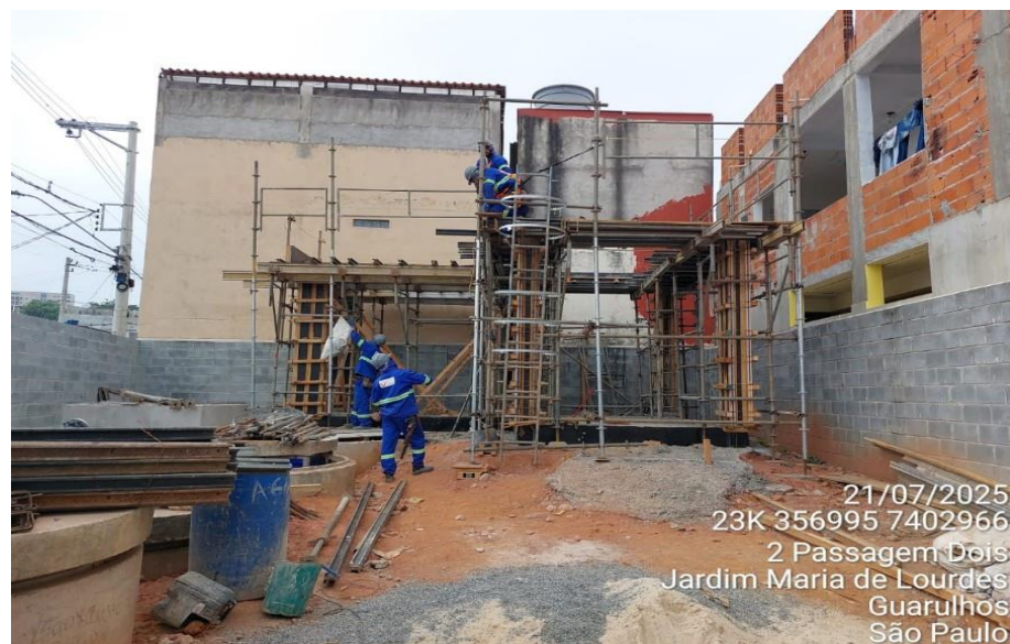
Execução de estrutura EEE EC-D1
