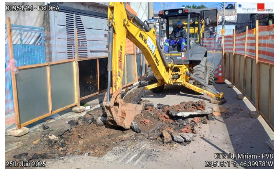
Execução de escavação
