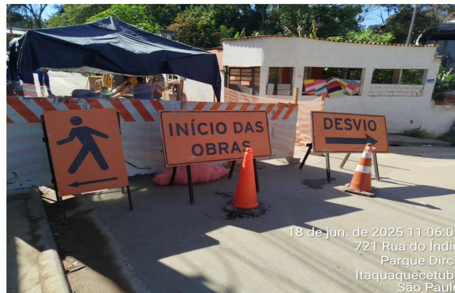
Execução de sinalização e isolamento para início de obras no Pq. Dirce
