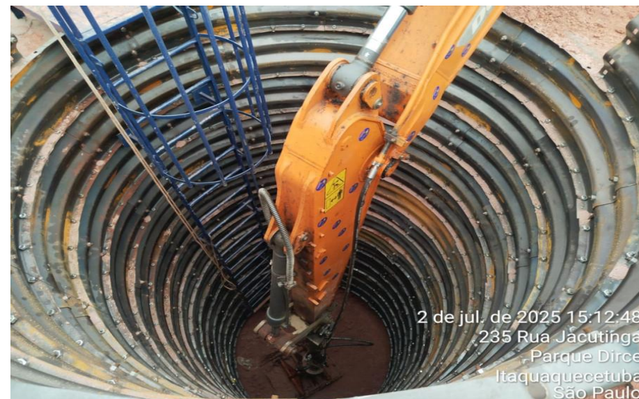
Execução de shaft
