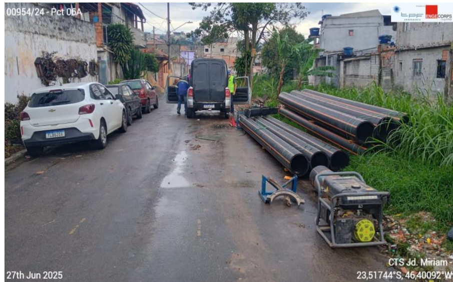
Execução de tubos e interligações
