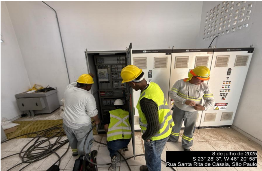
Execução de instalações elétricas
