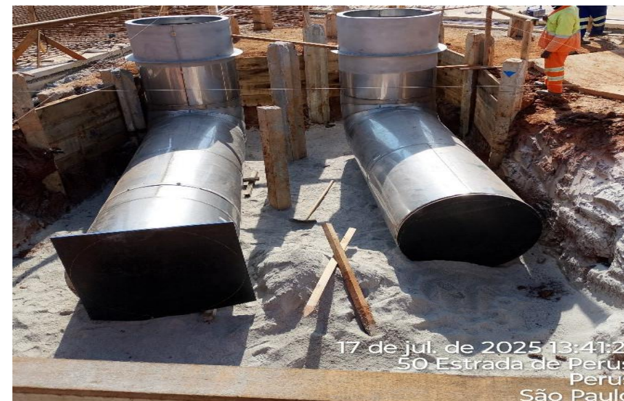
Execução de posicionamento dos inserts
