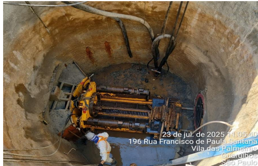
Execução de Coletor Tronco
