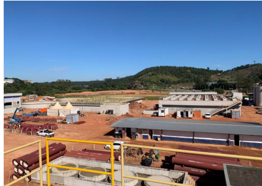
Dique de contenção dos tanques de HDX
