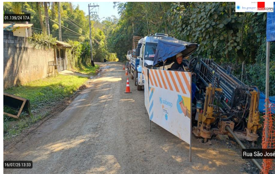
Execução de Furo Direcional
