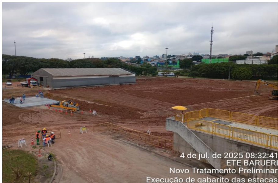
Execução de gabarito das estacas
