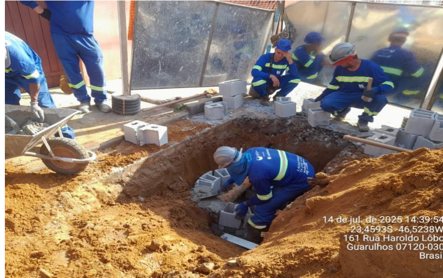
Execução de PV
