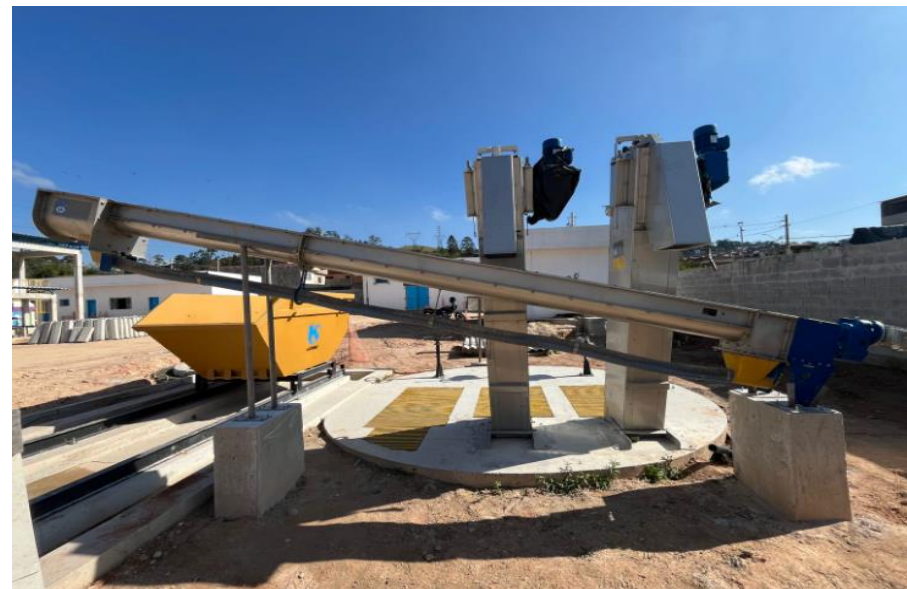
Execução das roscas transportadoras
