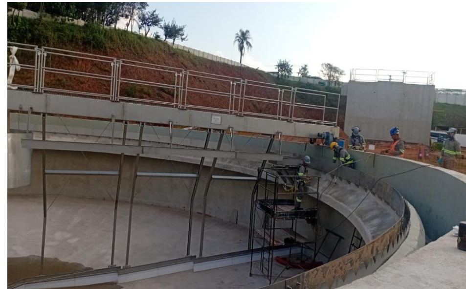
Montagem das Pontes Removedoras de Lodo dos Decantadores Secundários
