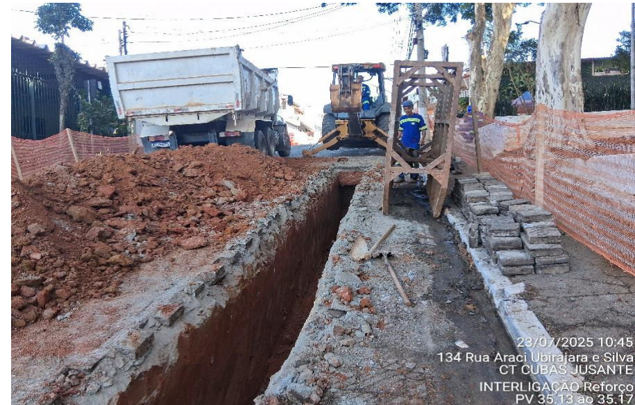
Execução de VCA
