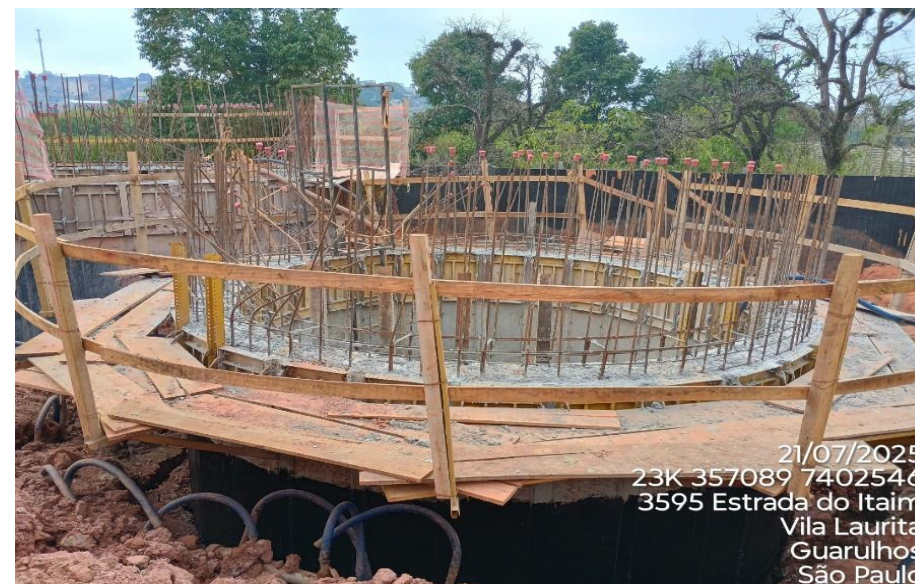
Execução de emissário – EEE7
