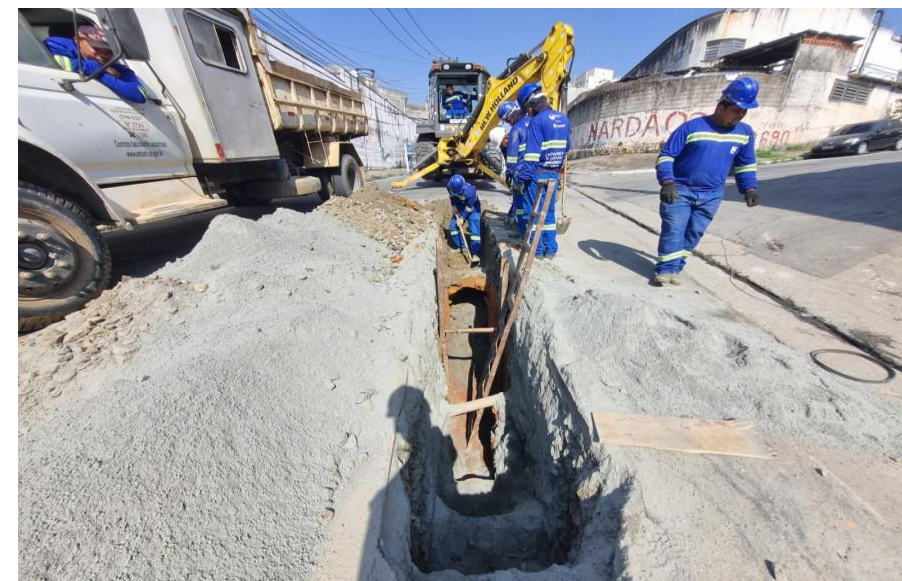
Execução de VCA
