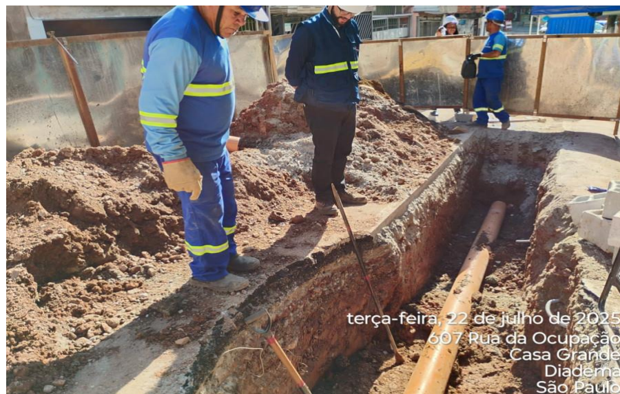
Execução de Interligações
