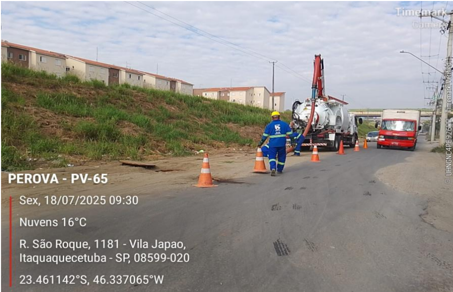
Execução do PV-65
