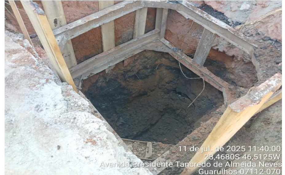
Execução de Escavação
