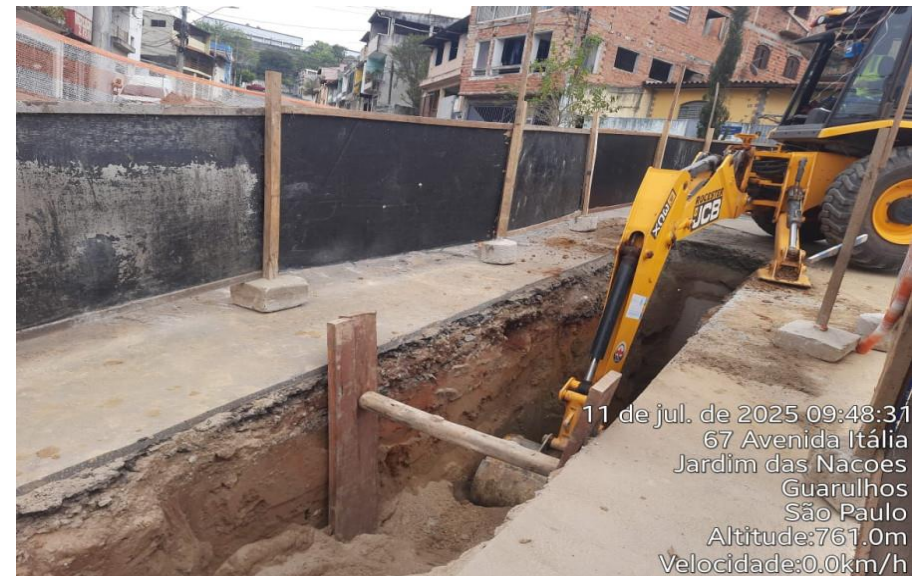
Execução de VCA
