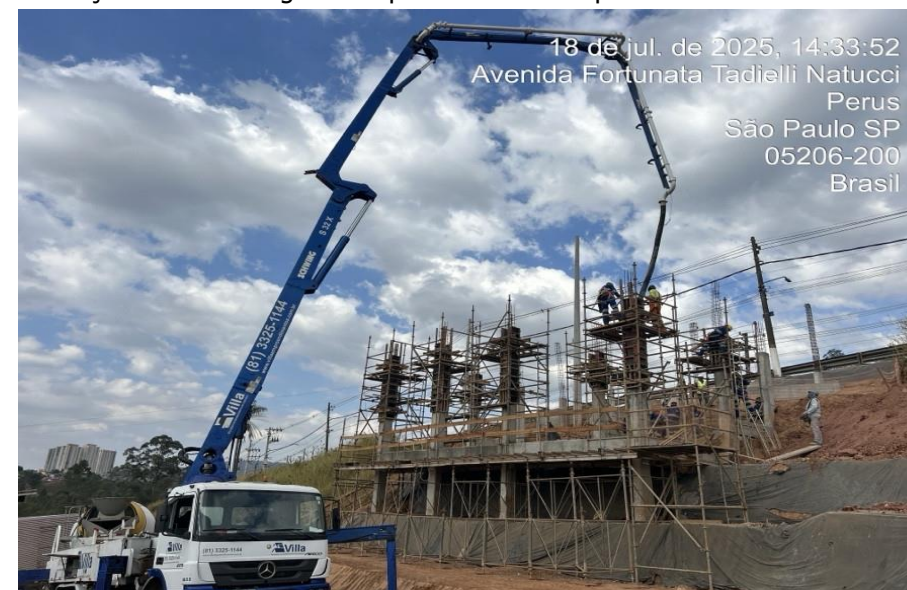
Execução da Concretagem dos pilares da cabine primária
