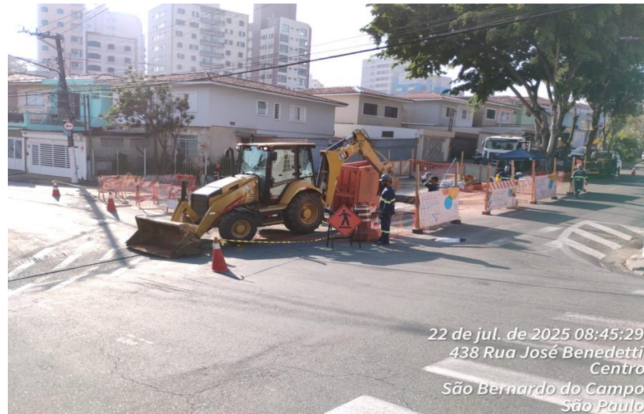
Execução de escavação
