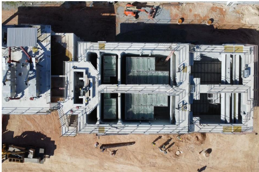
Execução do módulo de tratamento (TPC, reatores, etc)
