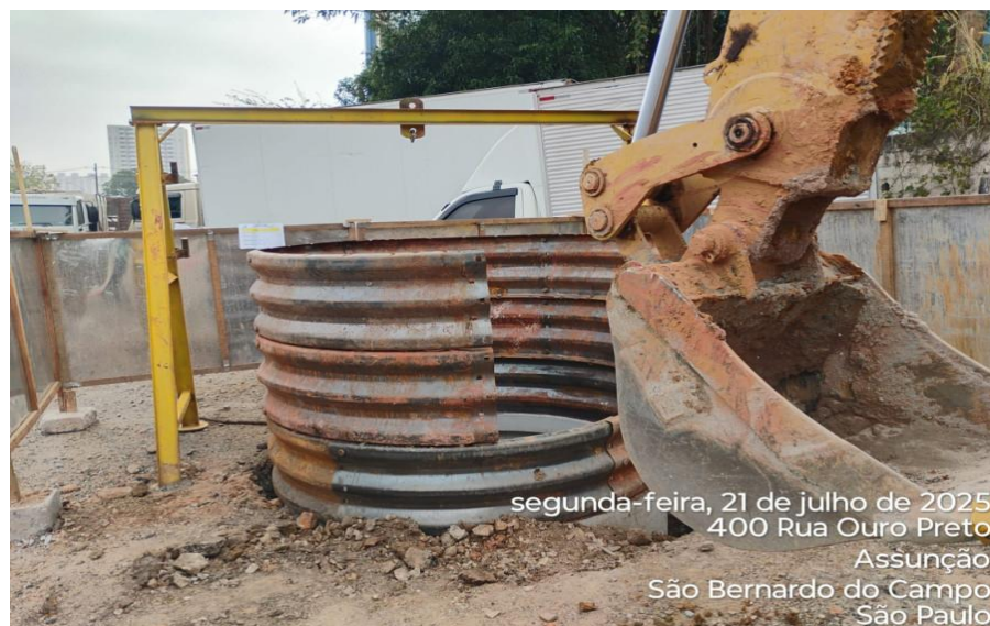
Execução de PV
