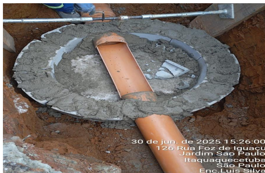
Execução de PI
