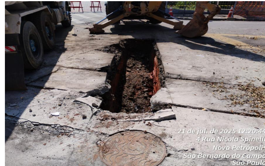
Execução de VCA
