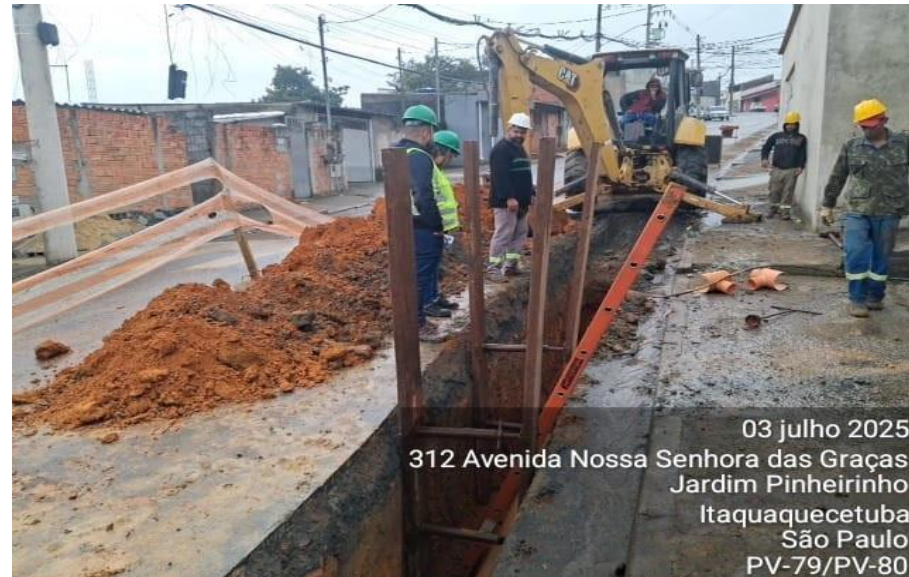
Execução de VCA
