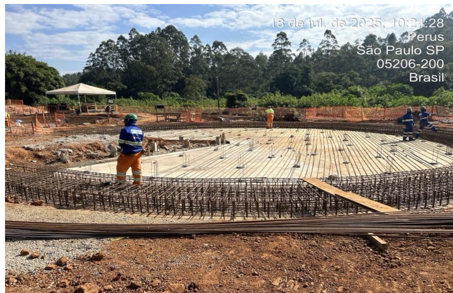
Execução da armação
