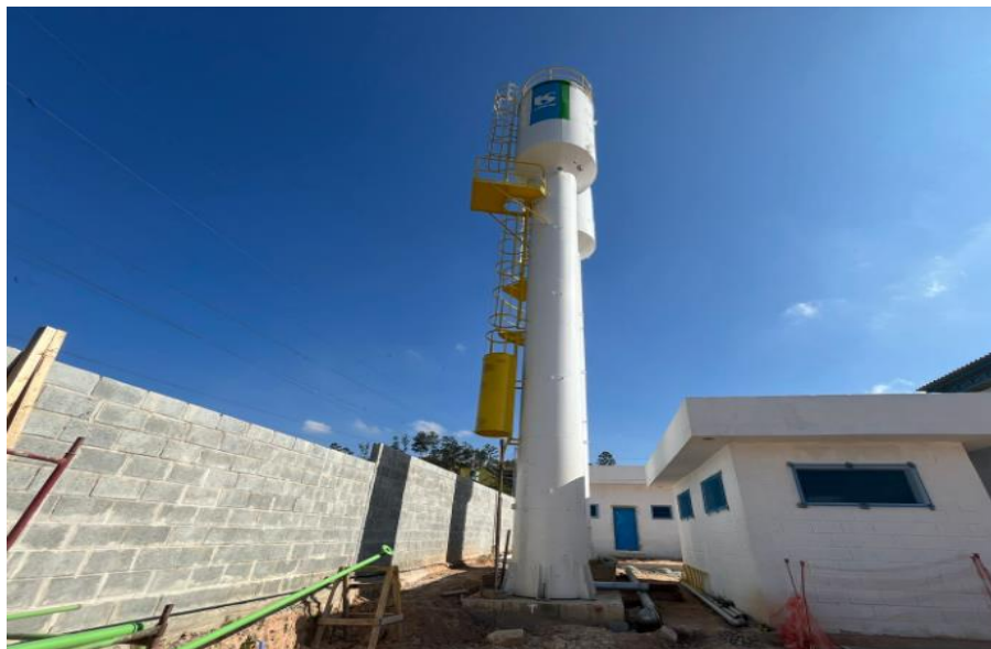
Execução dos reservatórios de água potável e água de reuso
