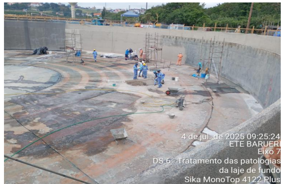
Execução de tratamento das patologias da laje de fundo
