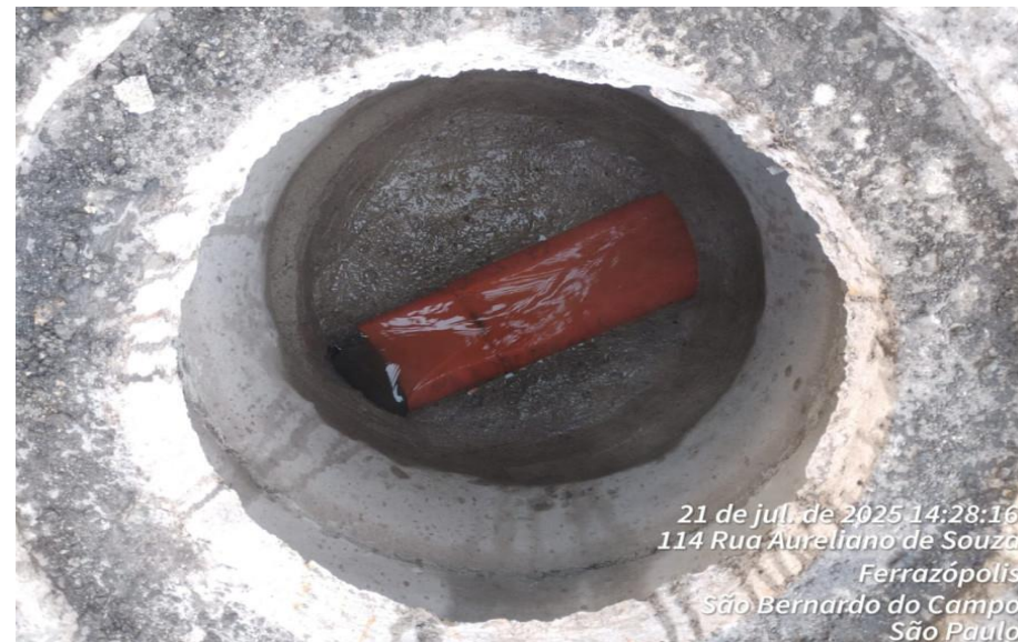
Execução de PI
