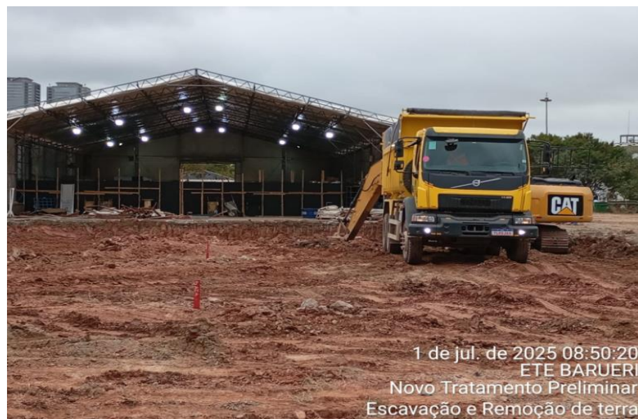
Execução de escavação e remoção de terra
