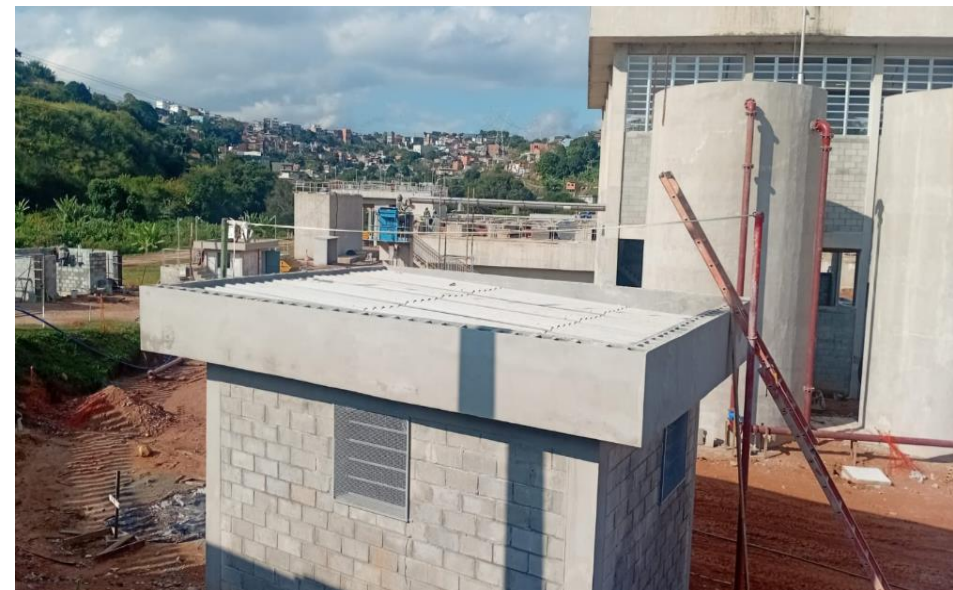
Impermeabilização da Laje da Subestação de Entrada
