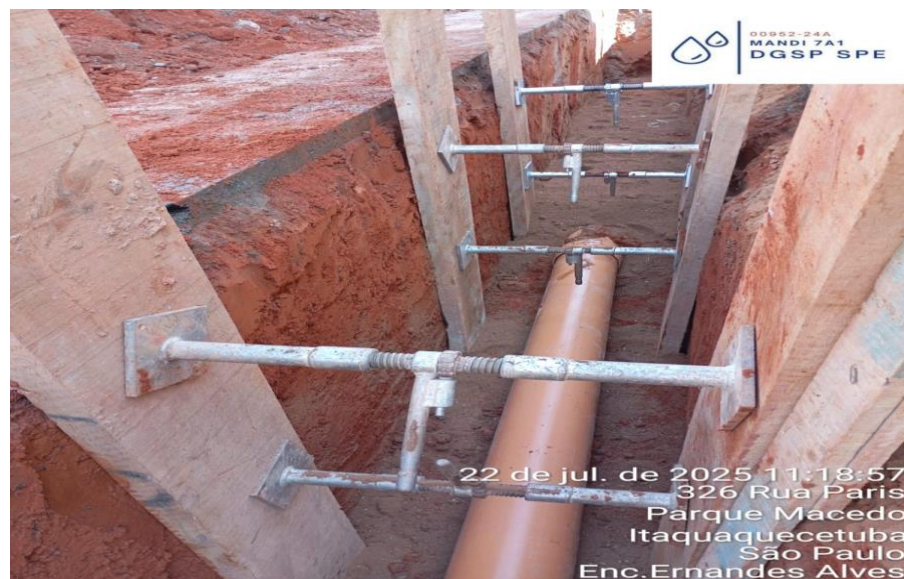
Execução de VCA
