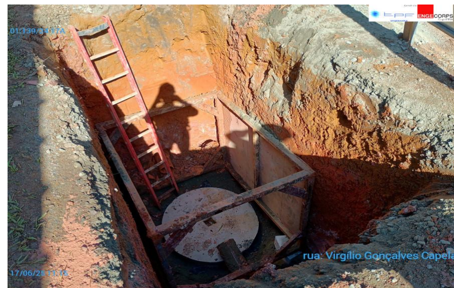
Execução de Rede coletora de esgoto
