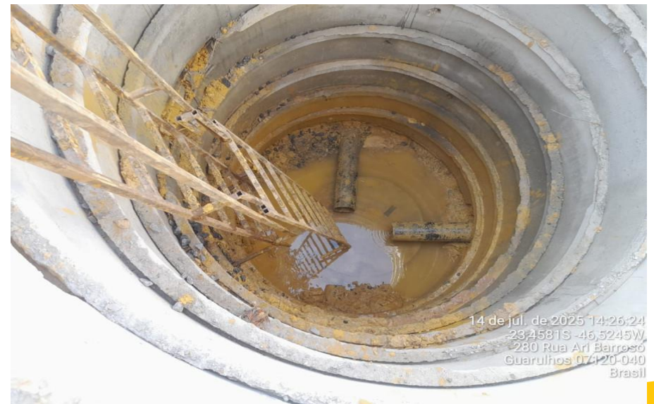
Execução de PV-317
