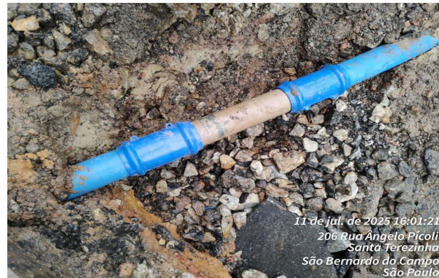
Execução de tubos e interligações
