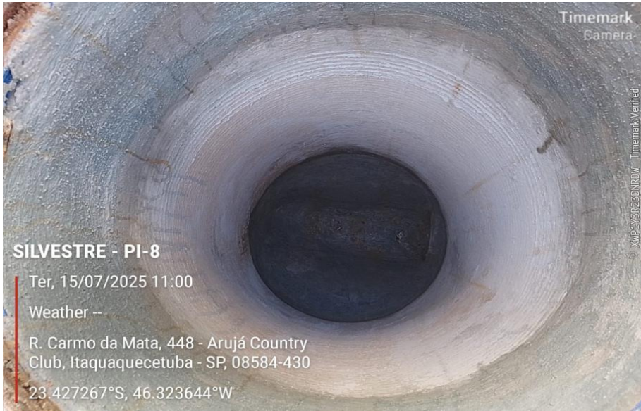
Execução do PI-8
