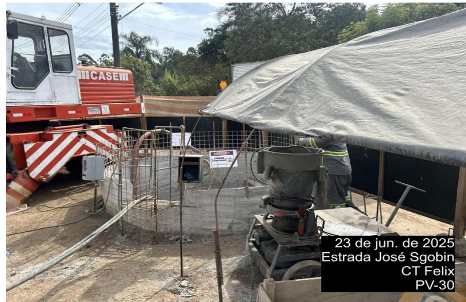
Execução do PV-30 CT Félix
