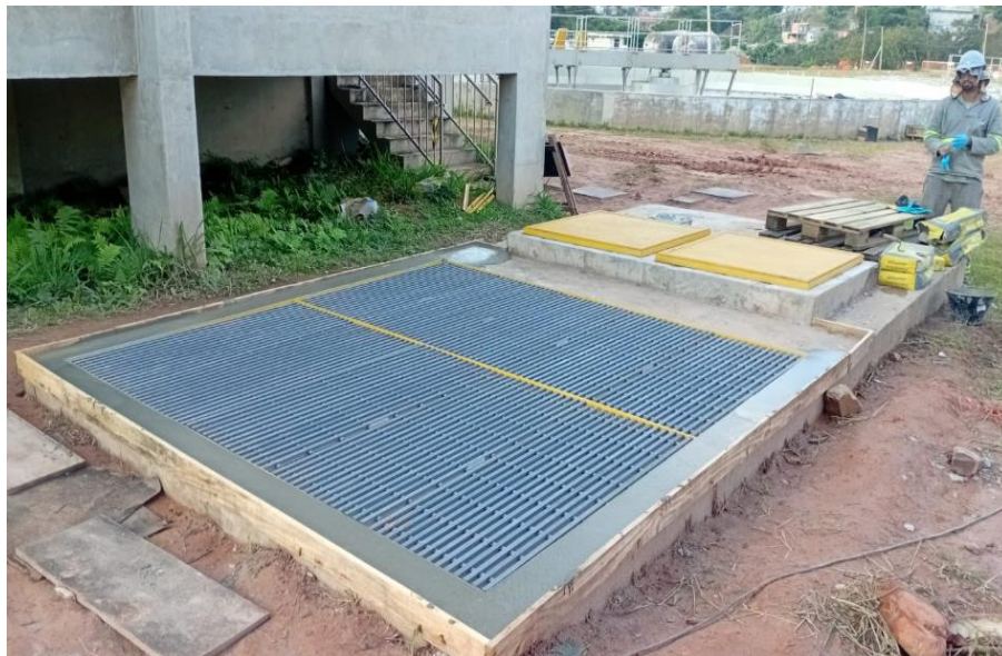
Montagem das Grades de Piso das Caixas de Manobra dos Decantadores Secundários
