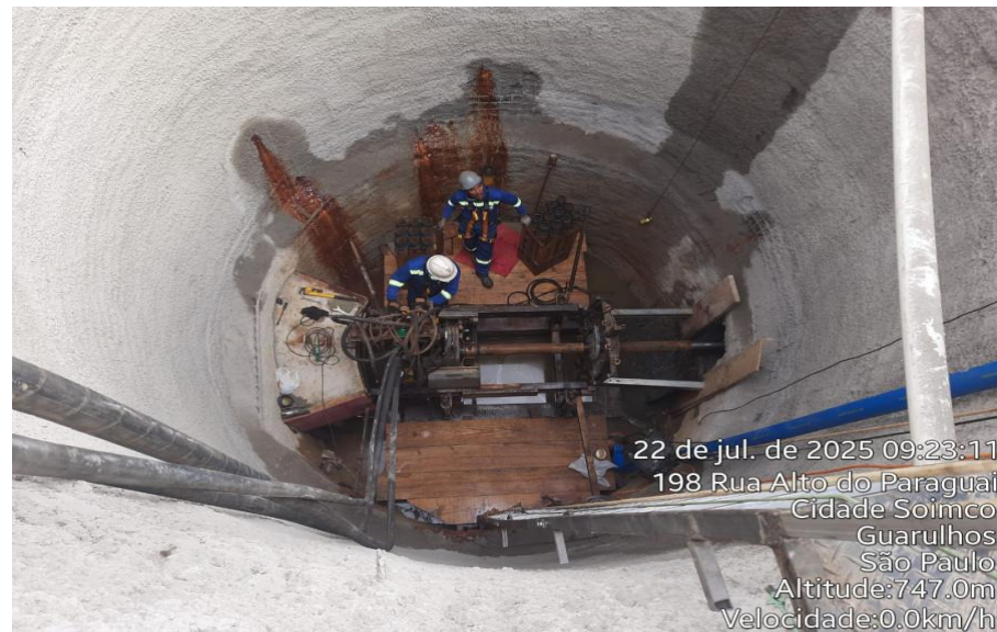
Execução de coletor tronco
