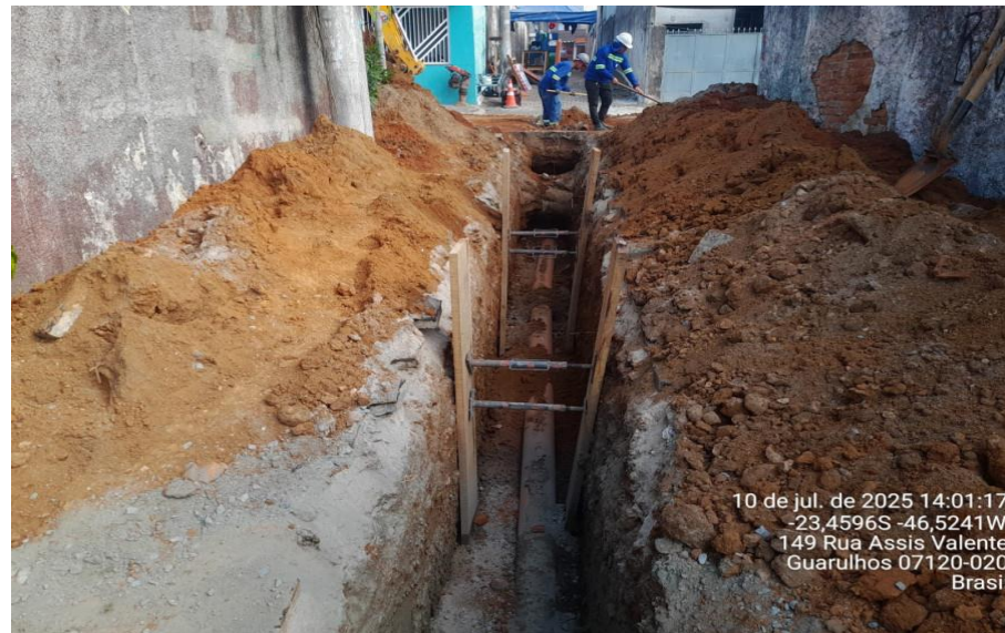
Execução de VCA
