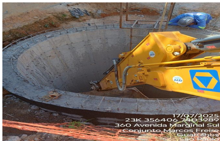
Execução de escavação
