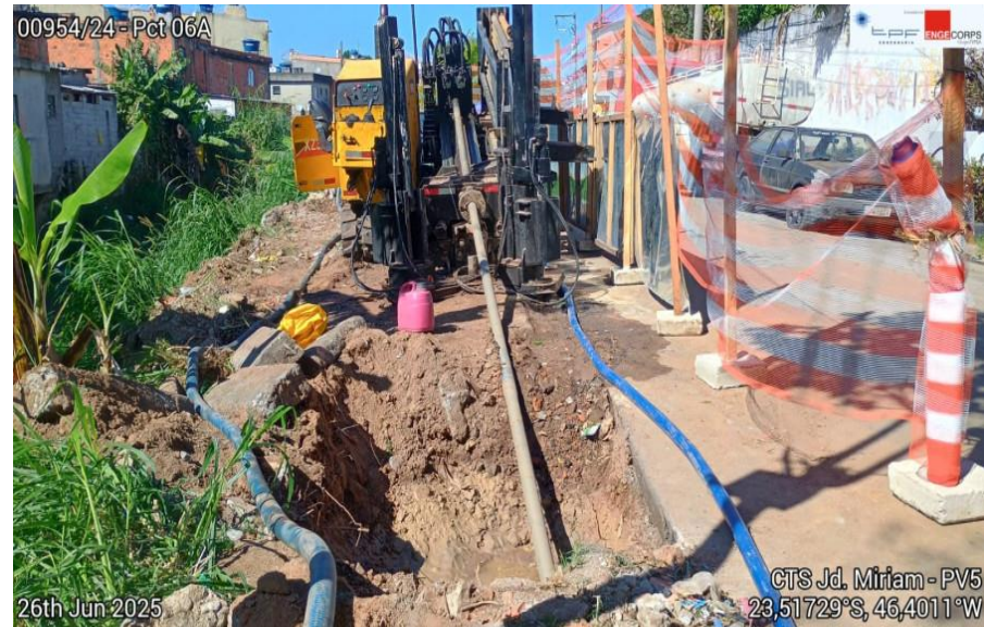
Execução de Furo direcional
