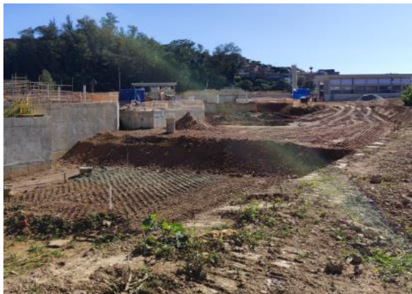
Movimentação e Compactação do solo
