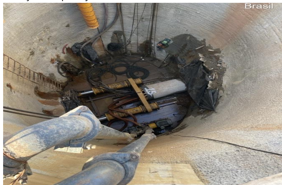
Execução da implantação dos sistemas de afastamento
