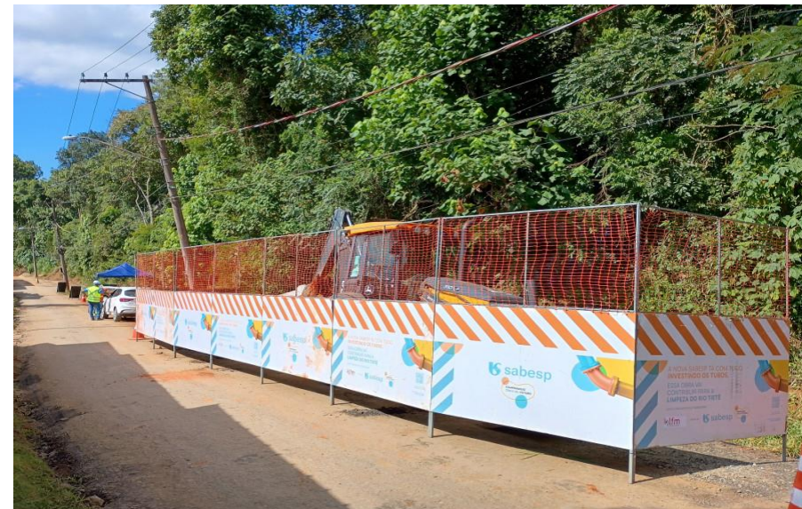
Execução de Rede coletora de esgoto Chácara Estância Paulista
