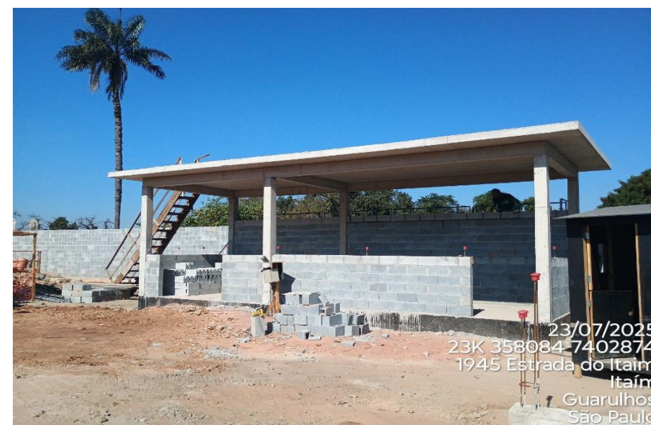
Execução de alvenaria da EEE EC-23B-3
