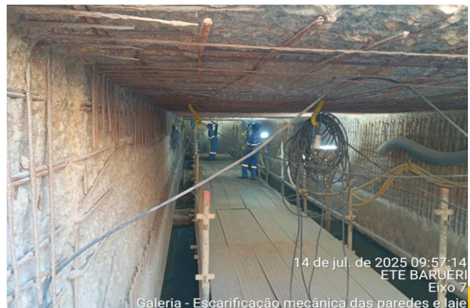
Execução de escarificação mecânica das paredes e lajes
