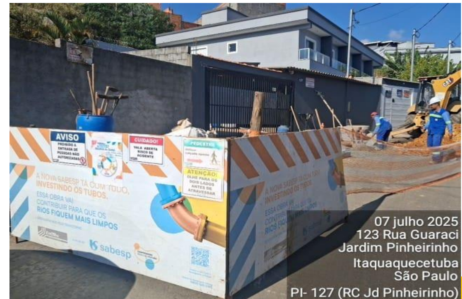
Execução de PI Jd. Pinheirinho
