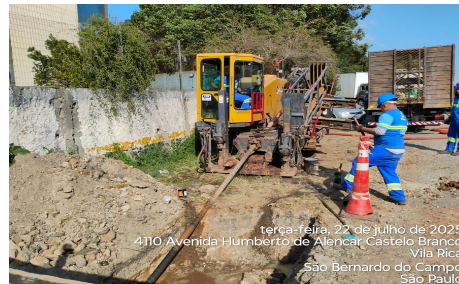
Execução de furo direcional
