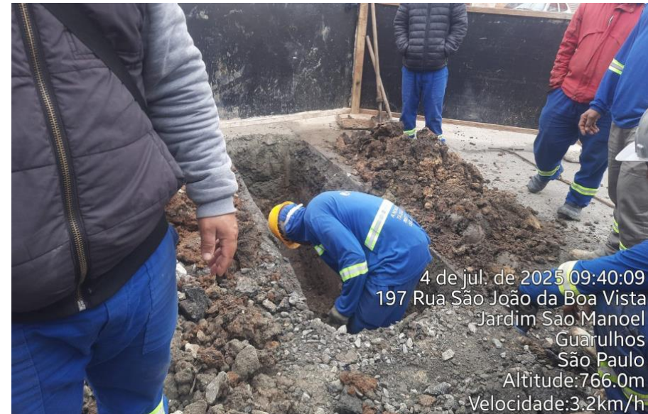
Execução de interligação
