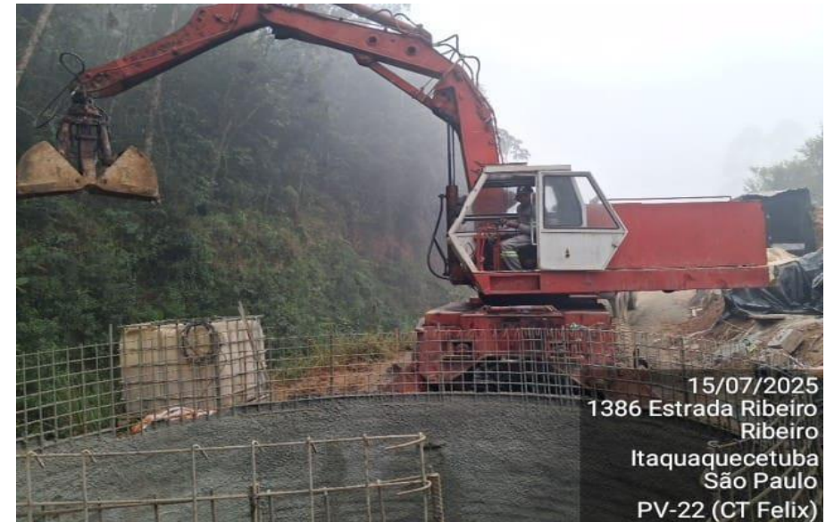
Execução do PV-22 CT Félix
