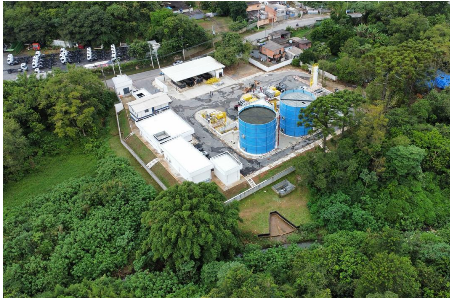
Vista Aérea da Planta Geral
