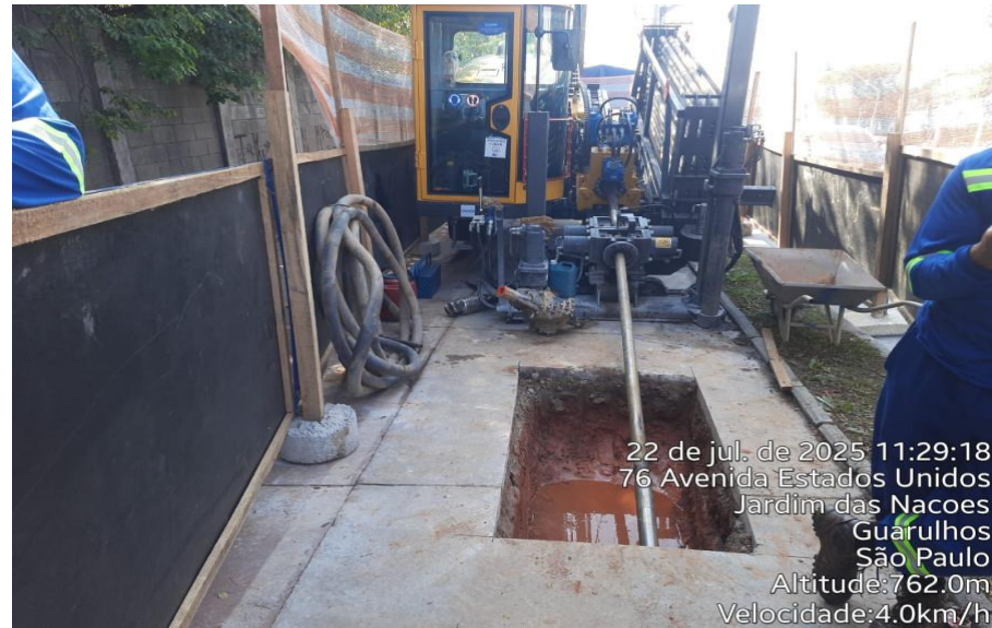
Execução de furo direcional
