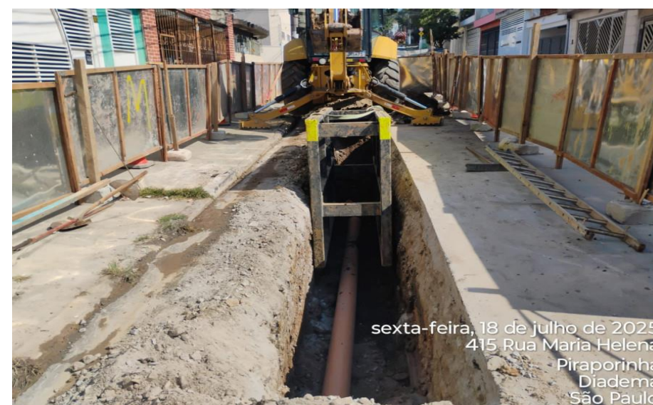
Execução de VCA
