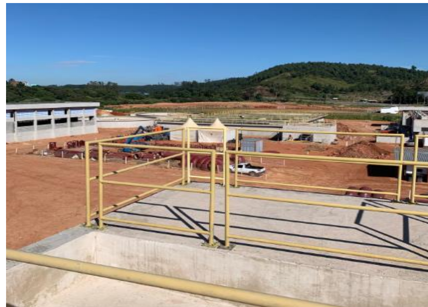
Dique de contenção dos tanques de HDX
