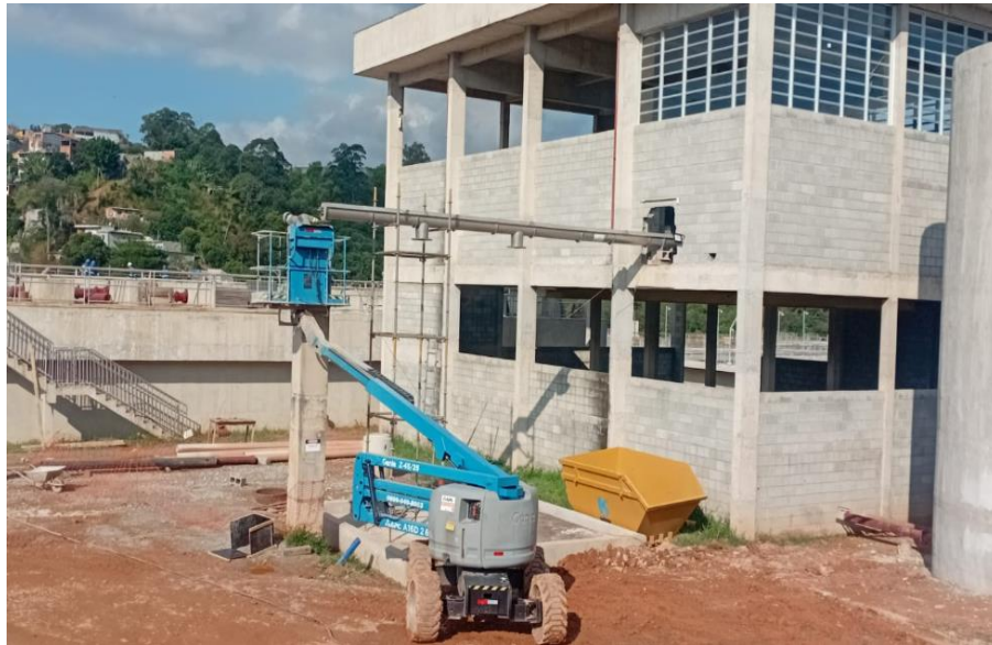
Instalação da Rosca Transportadora do Edif. de Sólidos
