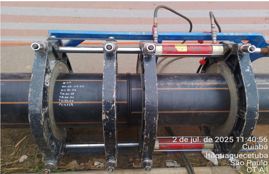
Execução de rede e coletores Jd. Rio Negro
