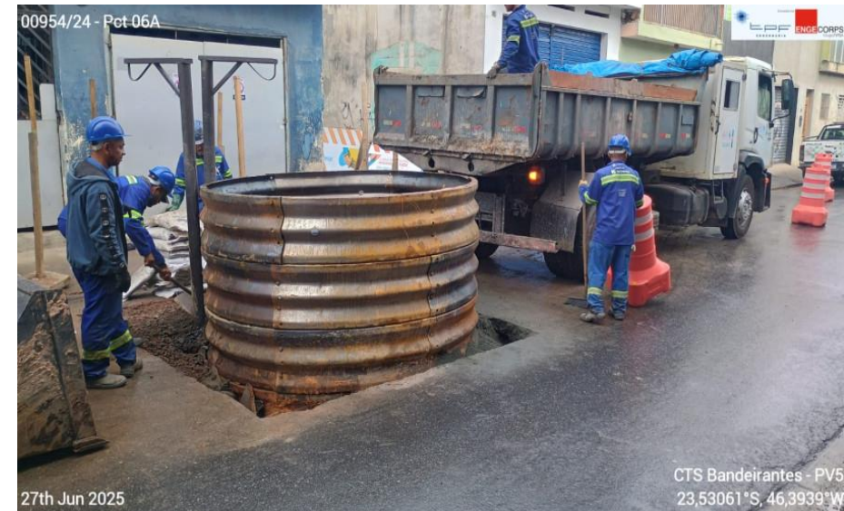
Execução de PV
