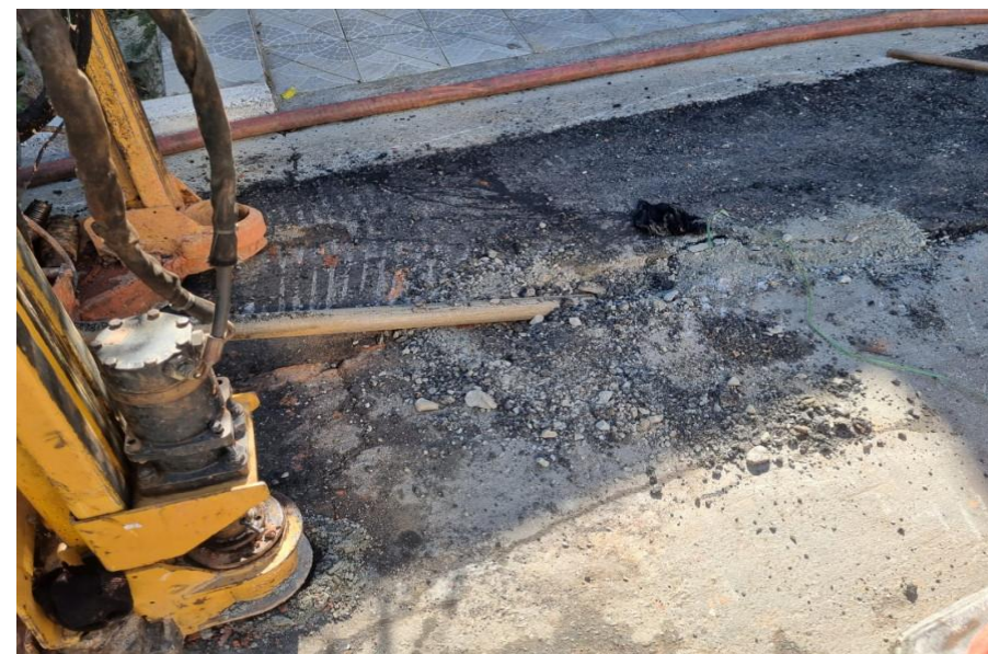
Execução de Furo Direcional
