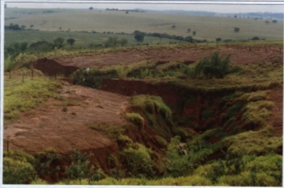
Foto 30. Boçoroca localizada em Santa Cruz do Rio Pardo, nas proximidades da rodovia Castelo Branco (SP-280), km 209, em área de média susceptibilidade a erosão. Tal feição erosiva foi ocasionada pelo mau dimensionamento do sistema de drenagem da rodovia.
