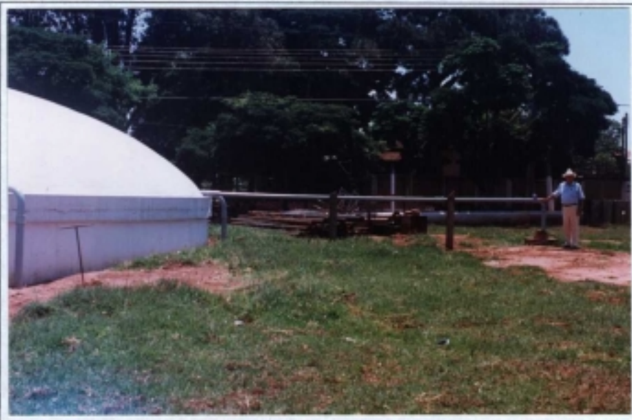
Foto 21. Poço tubular no sistema aquífero Bauru, localizado ao lado de reservatório de abastecimento público, em Rancharia.
