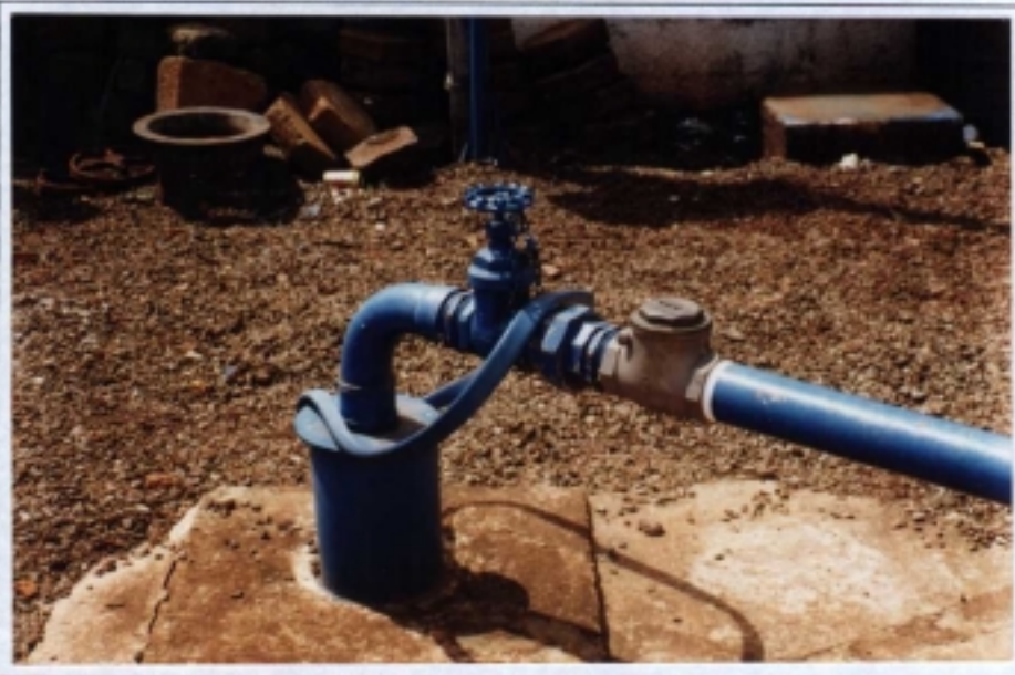
Foto 22. Poço tubular no Sistema aquífero Serra Geral, situado ao lado da sede do SAE (Serviço de Água e Esgoto) de Cândido Mota.
