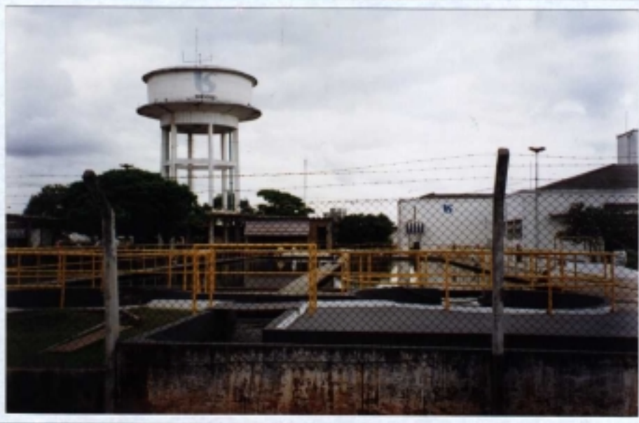
Foto 23. Estação de Tratamento de Água (ETA) da Sabesp, em Assis.
