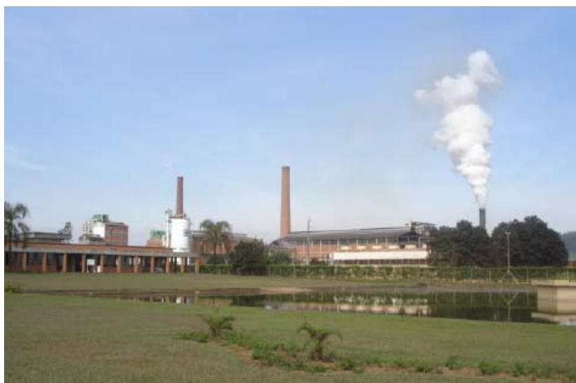
Figura 01: Apresenta uma vista parcial da LDC Bioenergia S/A.
