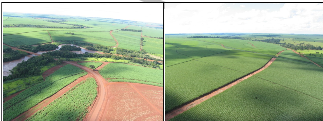
Foto VI.3.2.1-8 –Traçado do duto desprovido de vegetação. Apesar de estar em área com pouca declividade, isto pode potencializar processos erosivos e assoreamento de drenagem. Foto VI.3.2.1-9 - Traçado do duto desprovido de vegetação, podendo potencializar processos erosivos. Coordenadas 20256/7750720.
