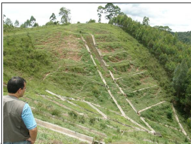
Foto VI.3.2.1-1 – Obra funcional de controle de erosão, com seqüência de canaletas longitudinais e transversais. Esta área é próxima ao contato dos granitos com os migmatitos do Complexo Pinhal em zona de falha. Coordenada 372526E / 7445289N
