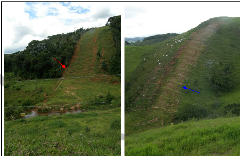
Fotos VI.3.2.1-3 - Encostas íngremes com predomínio de canaletas transversais (seta azul). Na escada e caixa de retenção na base do talude (lado esquerdo - seta vermelha). Coordenadas 379168 / 7445013 e 387579 / 7445850.
