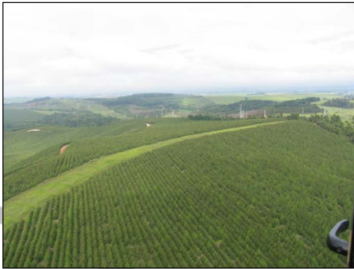
Foto VI.1-1 – Ilustração da faixa de servidão existente atravessando área de cultura (reflorestamento)
