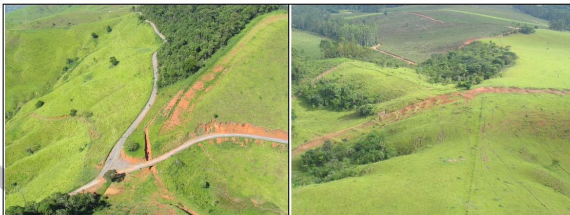
Foto VI.3.2.1-6 – Início de ravinamento próximo ao eixo do duto. Será necessária intervenção imediata. Coordenada UTM 391553/7446051 e Foto VI.3.2.1-7 – área com intenso pisoteio de criação. Poderá potencializar processos erosivos. Coordenada UTM 437333/7443476.
