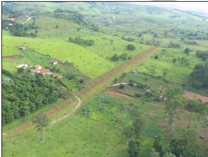
Foto VI.1-2 – Ilustração da faixa de servidão existente atravessando área de ocupação antrópica
