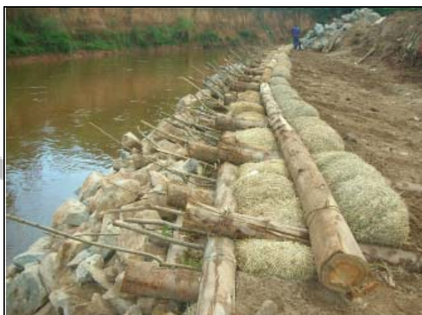
Foto VII.4.1.4-2 – Exemplo do uso de madeira, biomanta, aterro compactado e estacas vivas na proteção de margens de cursos d'água
