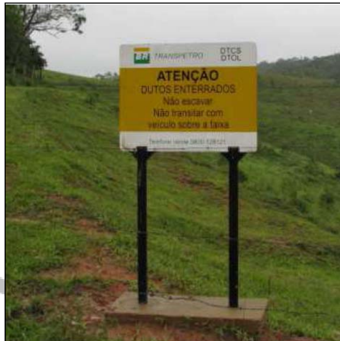
Foto VII.4.2.4-1 - Placa de Sinalização em Faixa de Duto. Fonte: PETROBRAS
