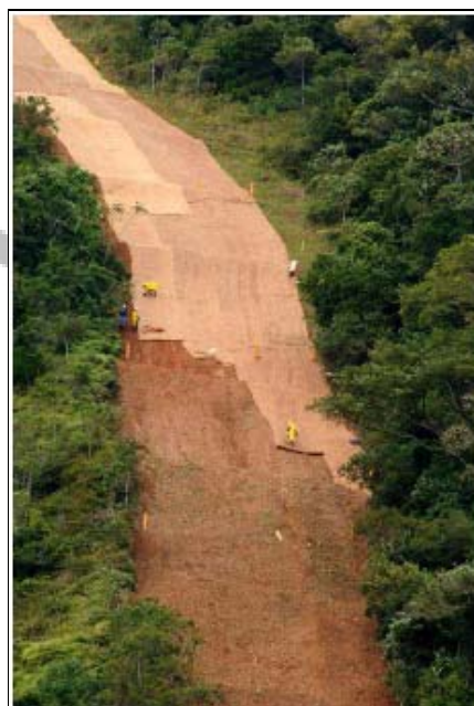
Foto VII.4.1.4-1 – Exemplo do uso de biomanta para a proteção de superfícies expostas
