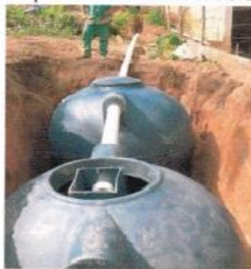
Tanque séptico e filtro anaeróbio (PEAD)
