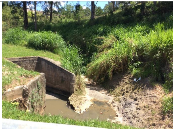
Foto 6.1.3.2-3: APP degradada, sem vegetação nativa, na altura do km 67+000, pista leste.
