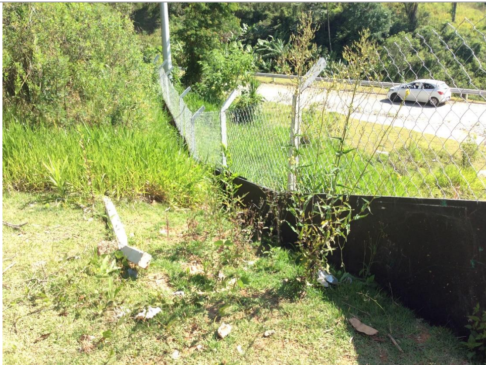
Foto 6.1.3.3-3: Detalhe para parte de cerca de direcionamento de fauna para passagem instalada na altura do km 59+000.
