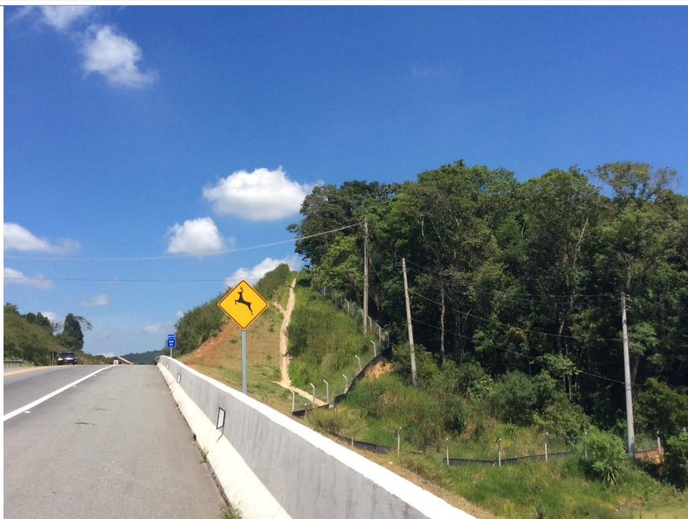
Foto 6.1.3.3-6: Placa alusiva a presença de animais silvestres na altura do km 59+000. Nota-se também cerca de direcionamento de fauna para passagem de fauna existente.
