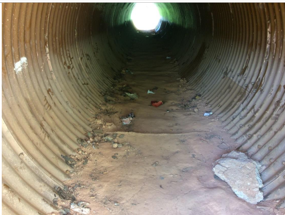
Foto 6.1.3.3-2: Interior da passagem de fauna seca, através de bueiro corrugado de 2m de diâmetro. Não foram observados vestígios de animais no interior da passagem durante a vistoria, em novembro/2017.
