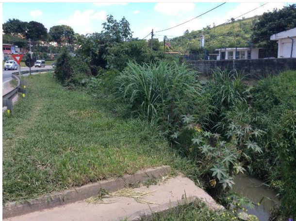
Foto 6.1.3.1-21: Área antrópica às margens do Ribeirão do Varjão, ocorrente na ADA, na altura do km 67+500, pista oeste.
