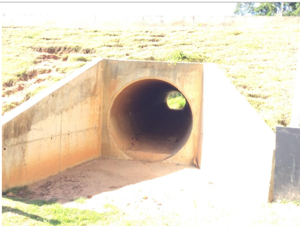
Foto 6.1.3.3-1: Vista parcial da passagem de fauna seca implantada na altura do km 59+000, em bom estado de conservação.
