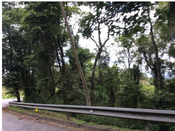
Foto 6.1.3.1-6: Vista detalhada para borda de fragmento florestal secundário de FODM em estágio médio, degradada, na ADA. Nota-se que o fragmento é melhor estruturado adentrando ao talude de aterro. Altura do km 49+800, pista leste.
