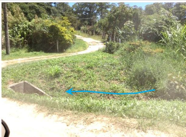
**Foto 33** – Vista do Ribeirão do Varjão pista sentido São Paulo na altura do km 78+300 da Rodovia, transição entre canal aberto e canalizado.
