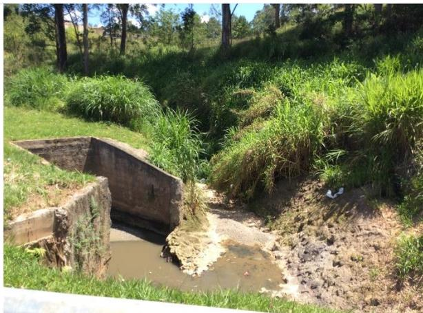
**Foto 15** – Assoreamento em curso d’água na altura do km 67+190 (feição nº 1 identificada), trecho suscetível à inundação.
