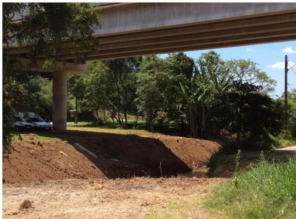
**Foto 37** – Ribeirão Guaçu retificado em canal aberto, travessia por OAE, altura do km 58+880 da Rodovia.
