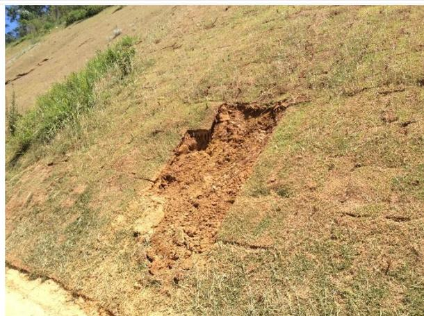
**Foto 20** – Escorregamento na base do talude na altura do km 72+660 (feição nº 6), em reparo no dia da vistoria.
