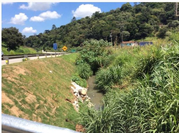
**Foto 19** – Erosão de margem em curso d’água na altura do km 68+040 (feição nº 5), trecho suscetível à inundação.
