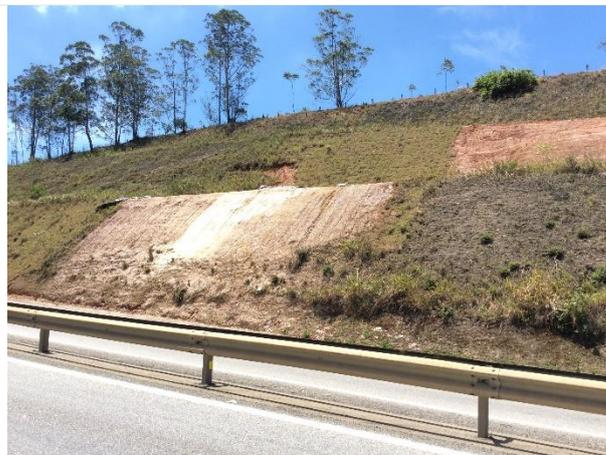
**Foto 22** - Processos erosivos no talude, altura do km 79+450.
