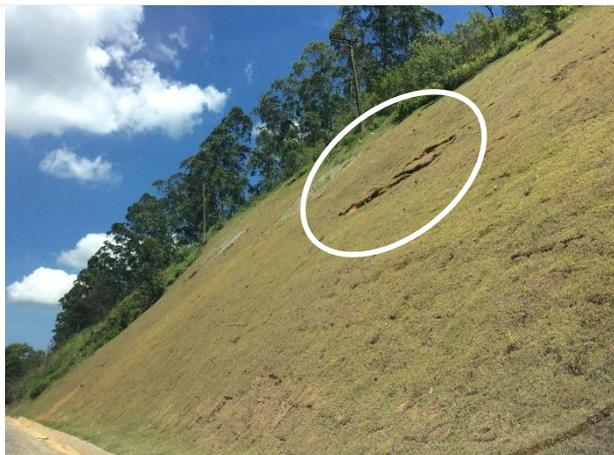
**Foto 21** - Escorregamento na meia altura do talude, no km 72+770 (7), em reparo no dia da vistoria.
