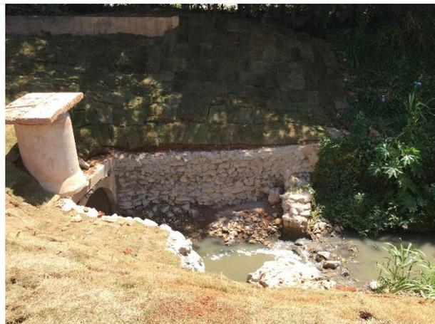
**Foto 16** – Feição existente de assoreamento de curso d’água na altura do km 67+940 (feição nº 2 identificada).
