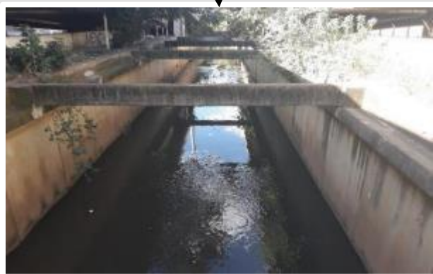
Córrego Água Espraiada – 14/06/2019
