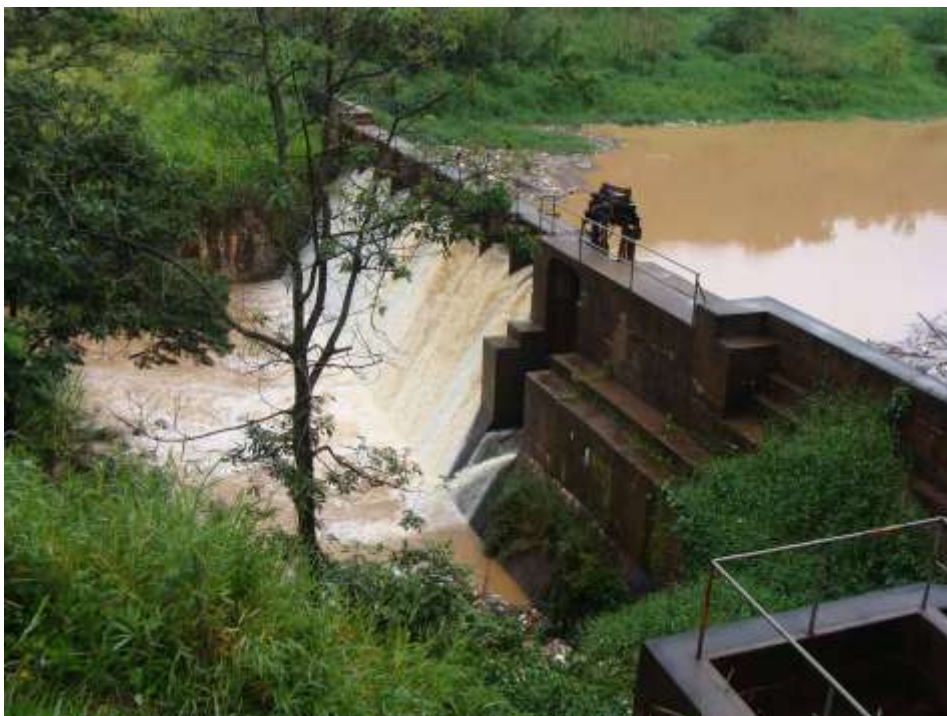
Figura 12: Barragem da CGH Poço Fundo com Tanque de Dissipação.
